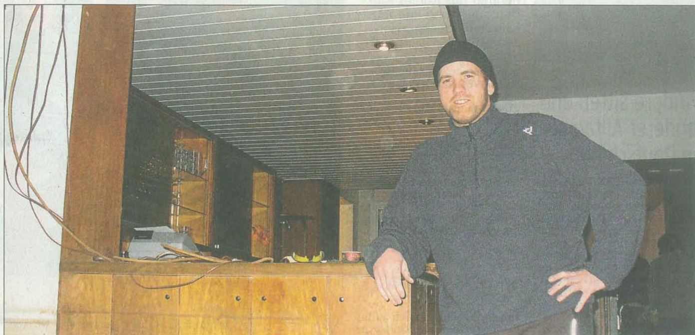
Der künftige Konzessionär Ralf Hoffmann hat sich schon einmal an der Theke platziert. Obwohl jetzt noch eine große Baustelle, sollen hier schon ab Mai die Gäste bewirtet werden. Fotos: Ulrich Schwind
